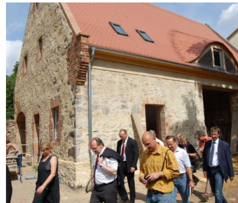
Pfarrscheune beim Umbau (Dach und Fassade sind bereits fertiggestellt) zur „BioGartenKüche“ LEADER Programm
