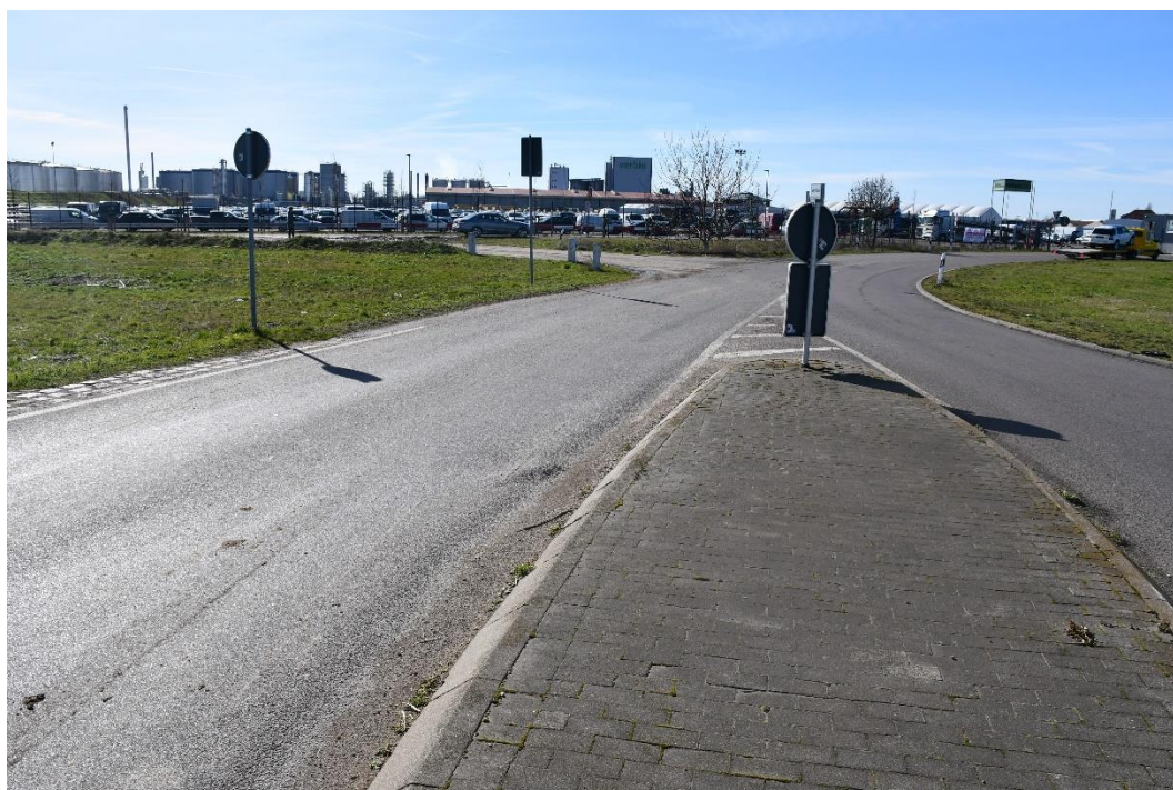
Foto: G. Sparfeld, Blick Richtung Süden zum Gewerbegebiet
